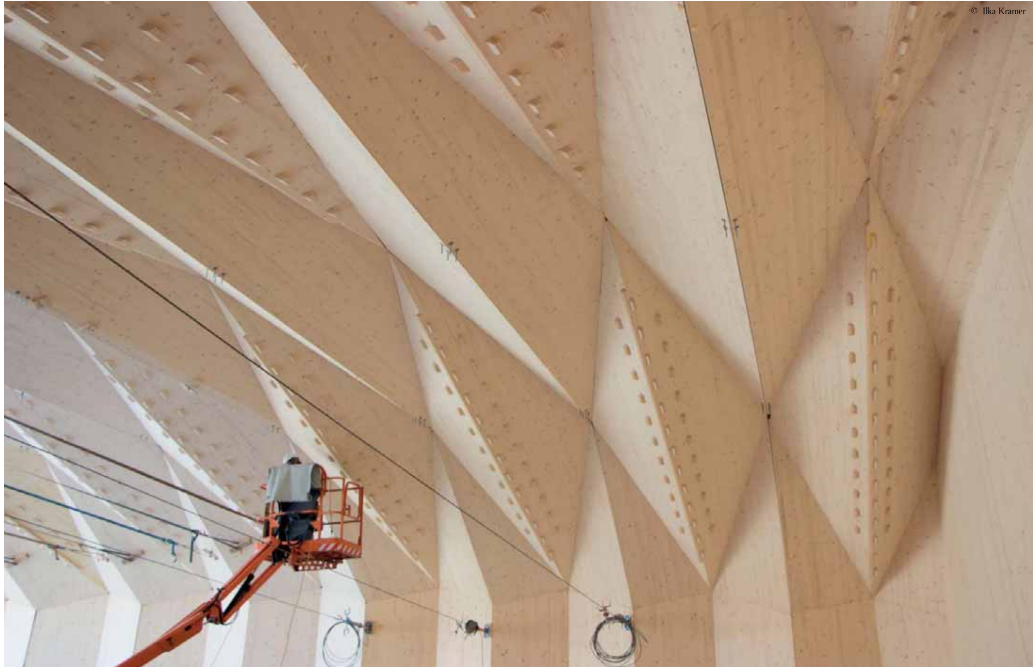
Struktur aus gefalteten Platten im Bau
