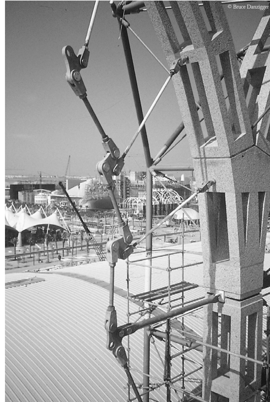
Steinbogen vor dem Einheben und Bogen und Verankerungssystem vor dem Spannen des verankerten Innenrings
