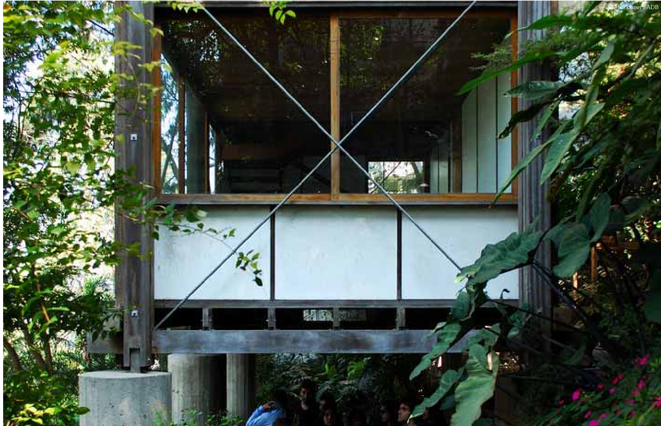
Detail der Fachwerkkonstruktion an den Stützenköpfen
