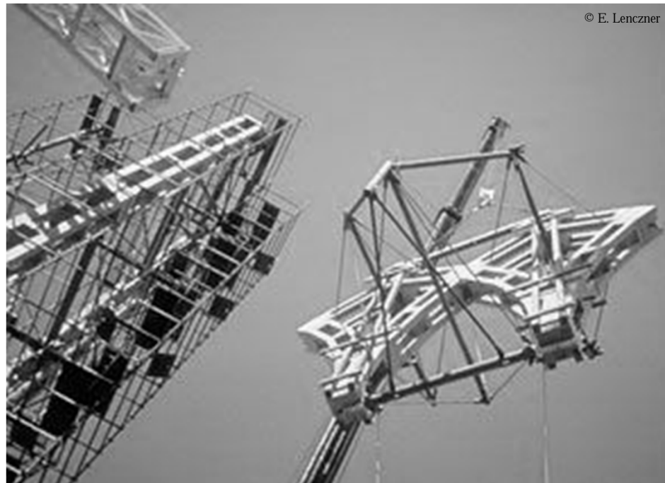
Module zwischen den Säulenmodulen und Bögen
