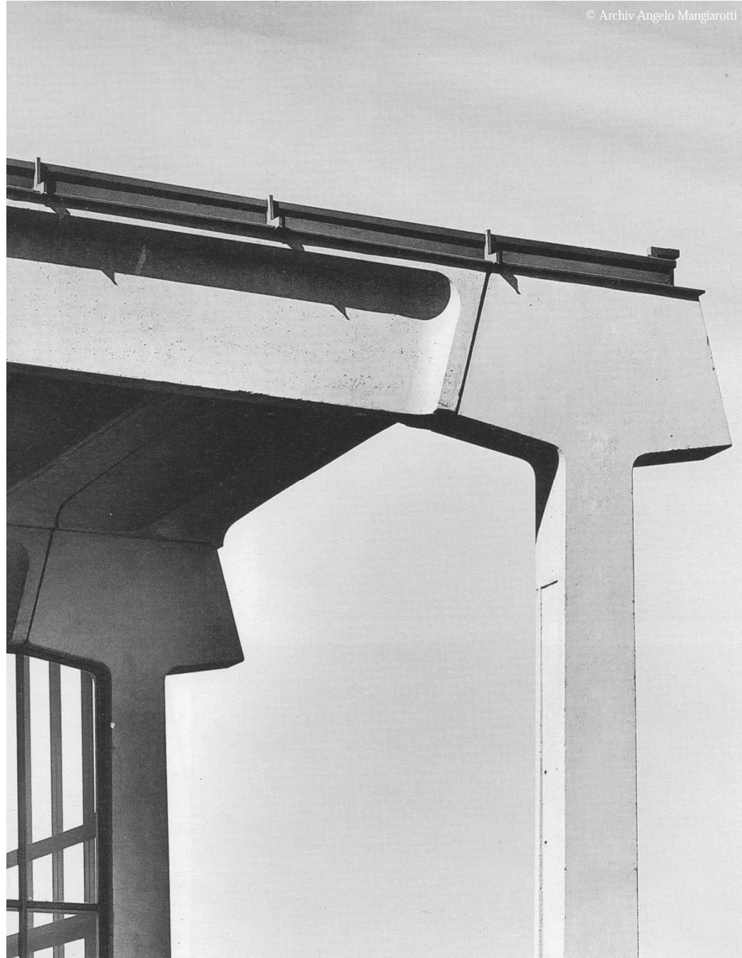
Vorgefertigtes System von Trägern und Stützen
