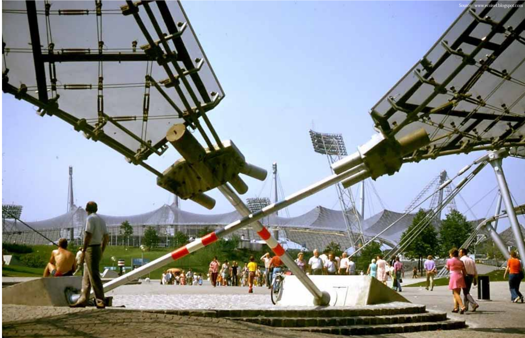
Auflagerbereiche von Kabelnetztragwerken
