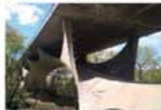
1976: Ponte sul Basento (Musmeci)
