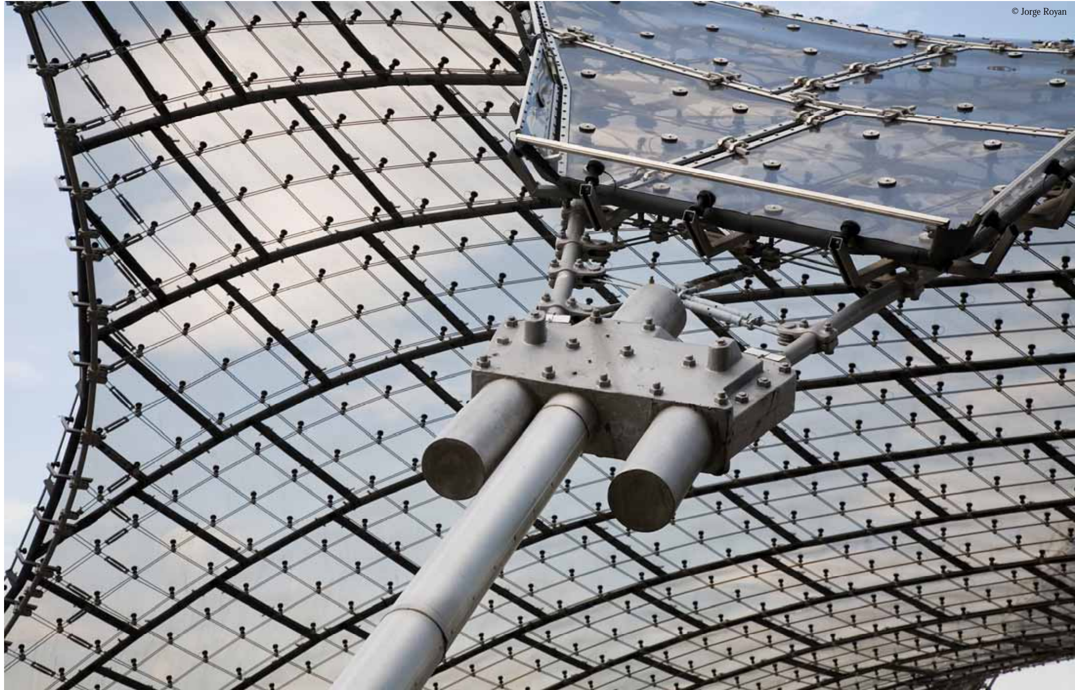
Auflagerbereiche von Kabelnetztragwerken
