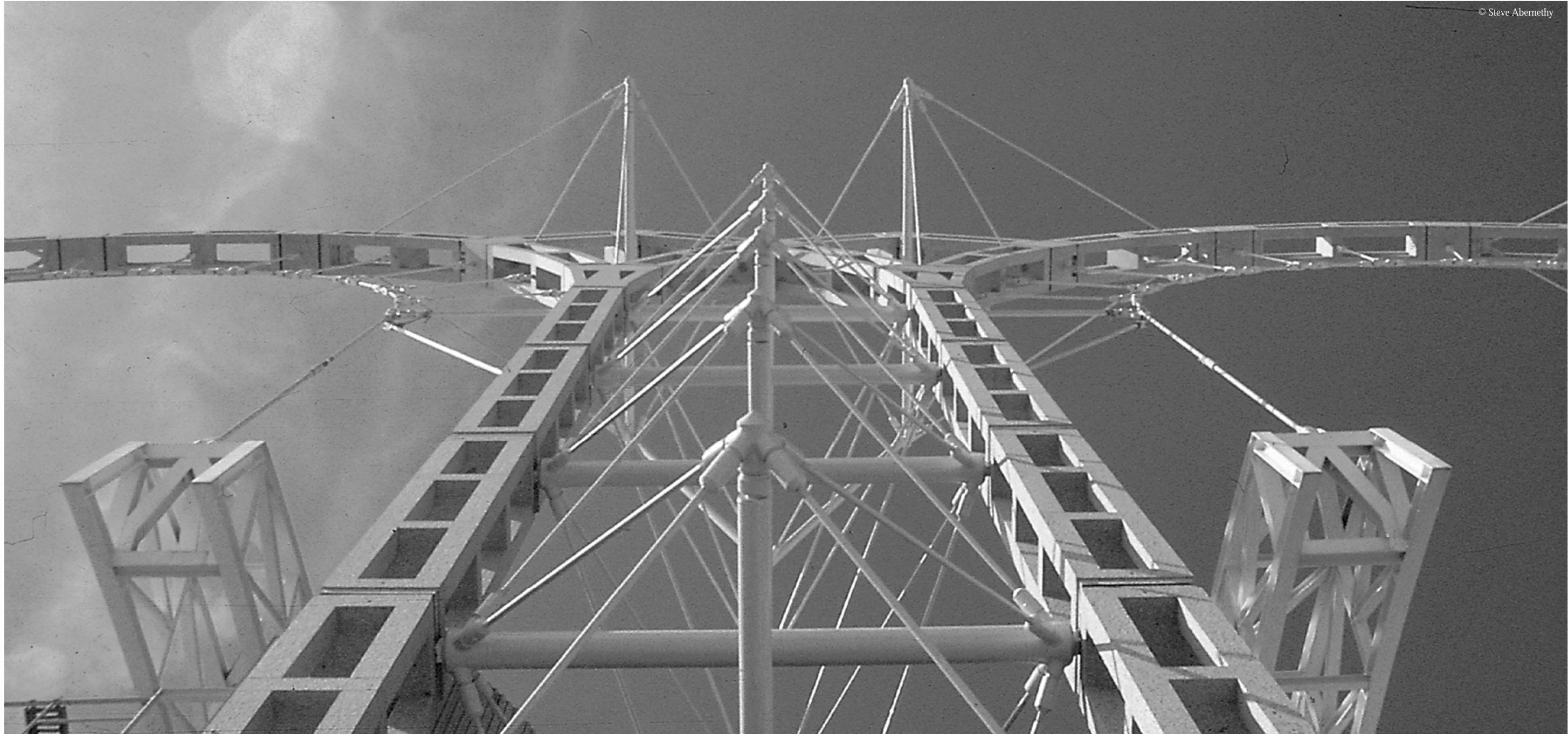
Fertige Bögen mit an Hängern aufgehängten Dachbalken
