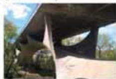
1976: Ponte sul Basento (Musmeci)
