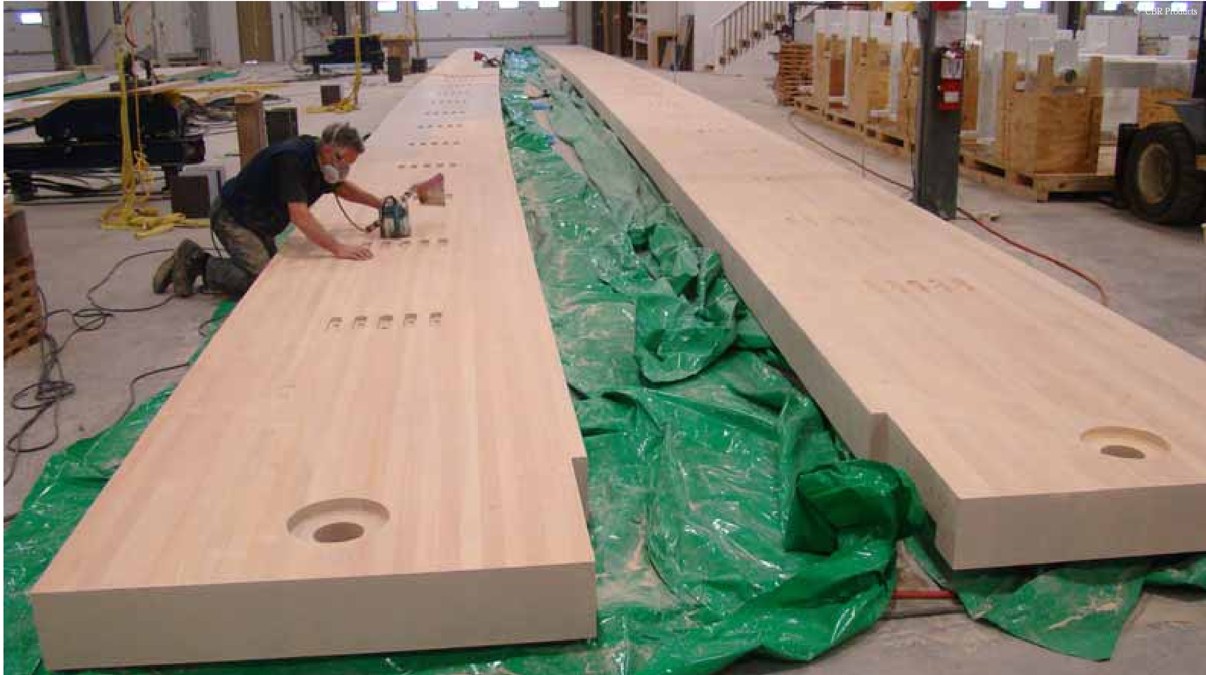
Balken aus Brettschichtholz
