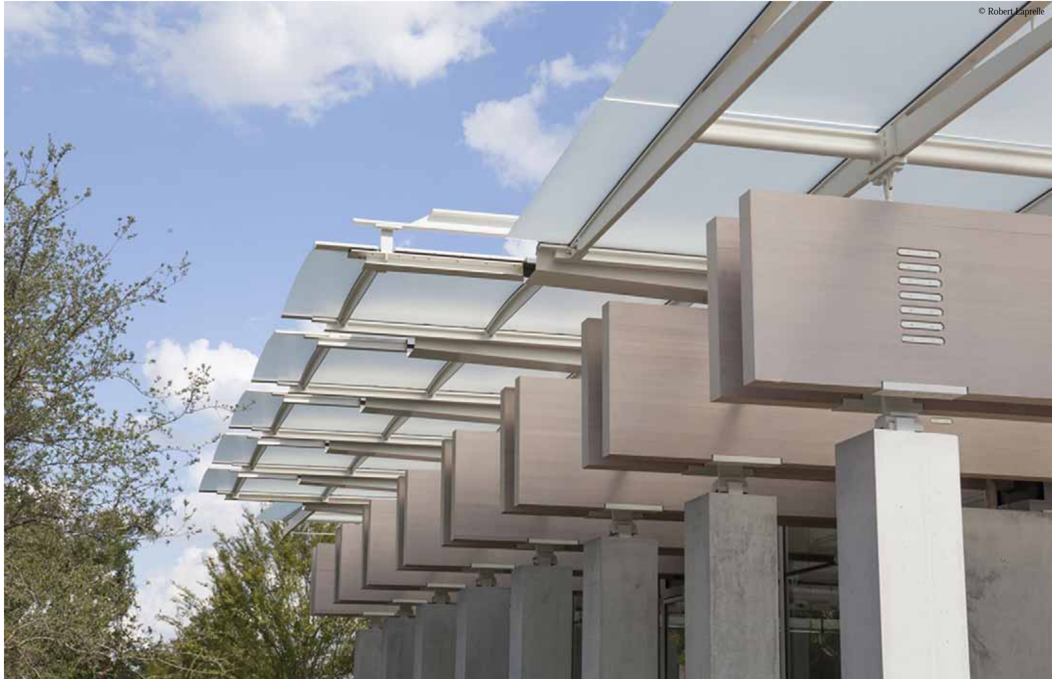
Verbindung zwischen den Brettschichtholzträgern und den Betonstützen
