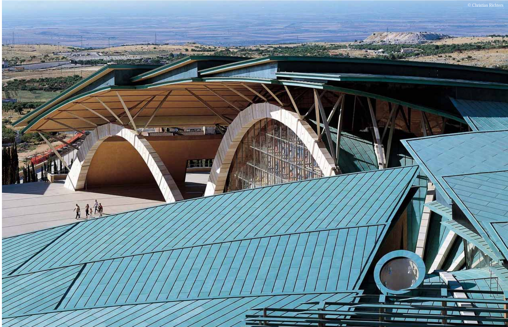
Blick auf das Dach und den Haupteingang
