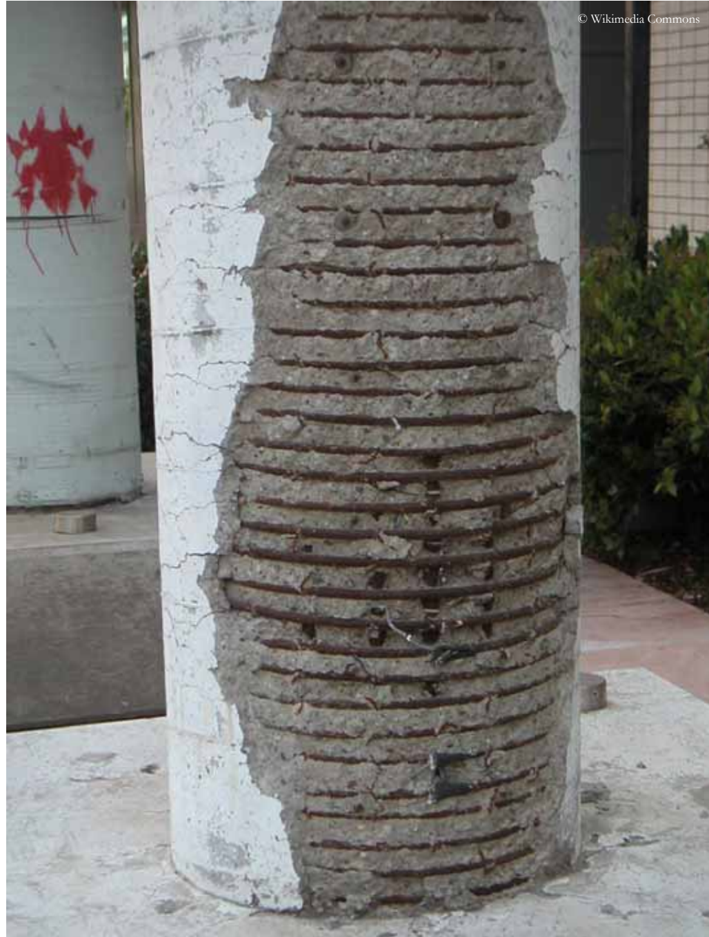
Karbonatisierung an einer Stahlbetonstütze Carbonation on a reinforced concrete column
