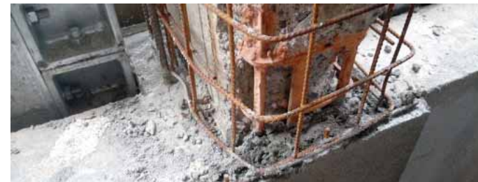
Ersatz von Bewehrungsstäben Rebars substitution
