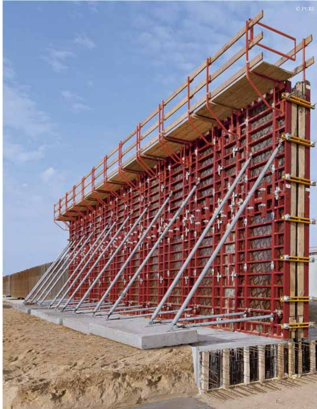
Wiederverwendbare Schalung für Wände Reusable formwork for walls
