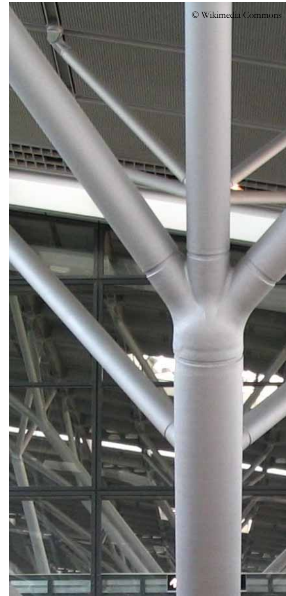
GESCHWEISST WELDED (Stuttgart Airport)
