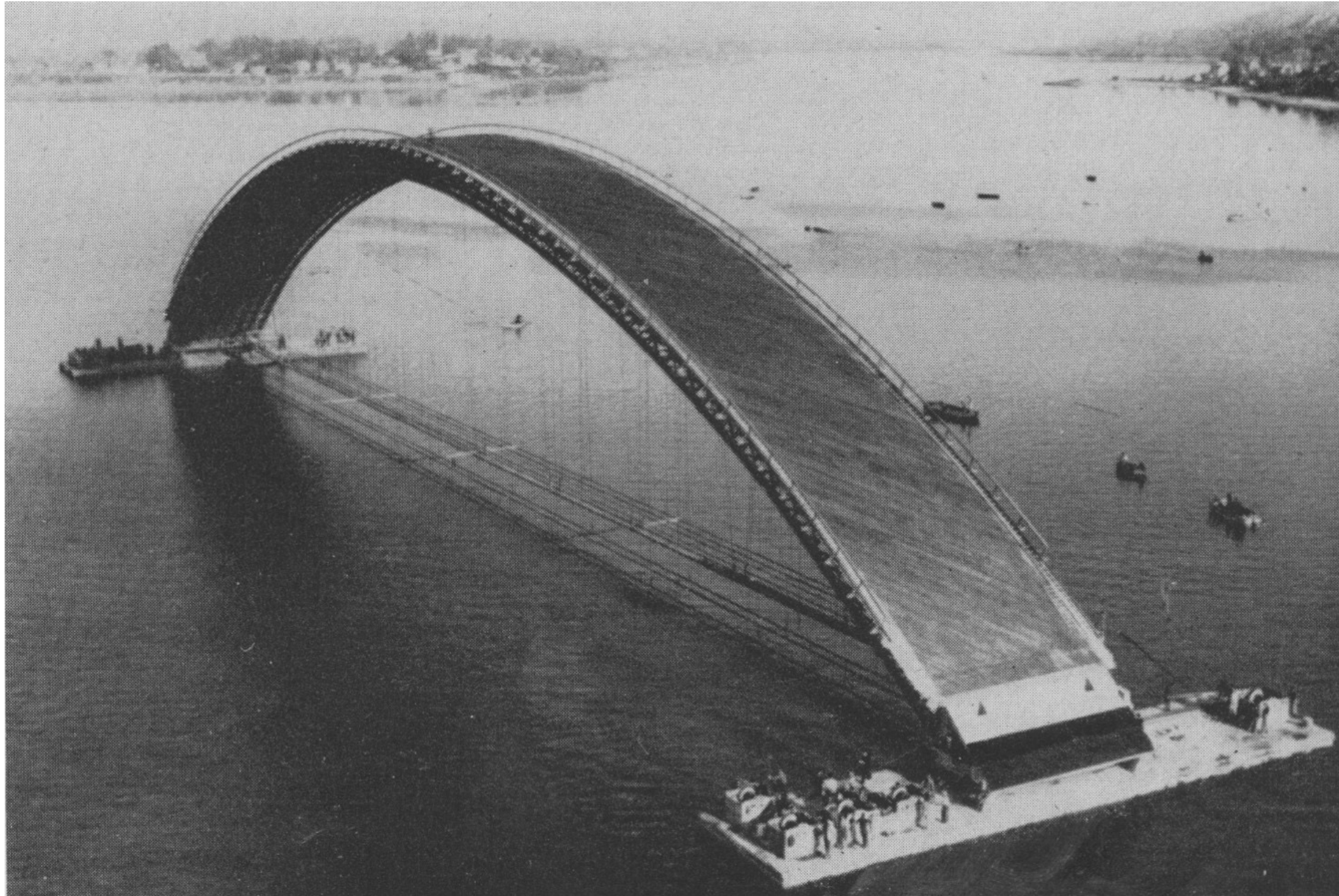
Eugène Freyssinet: Pont Albert Louppe, Bretagne, 1930
