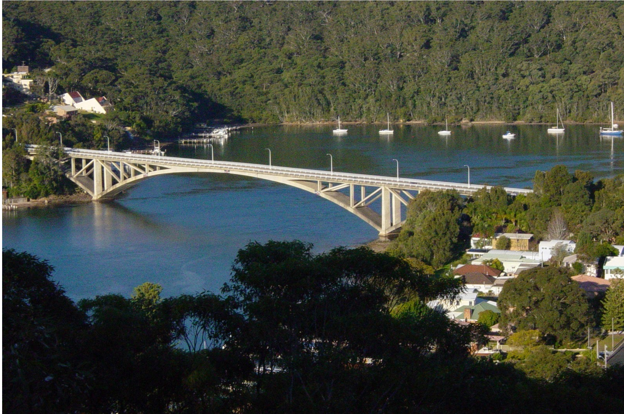
A. Fried: Rip-Bridge, Woy-Woy, Australien, 1971
