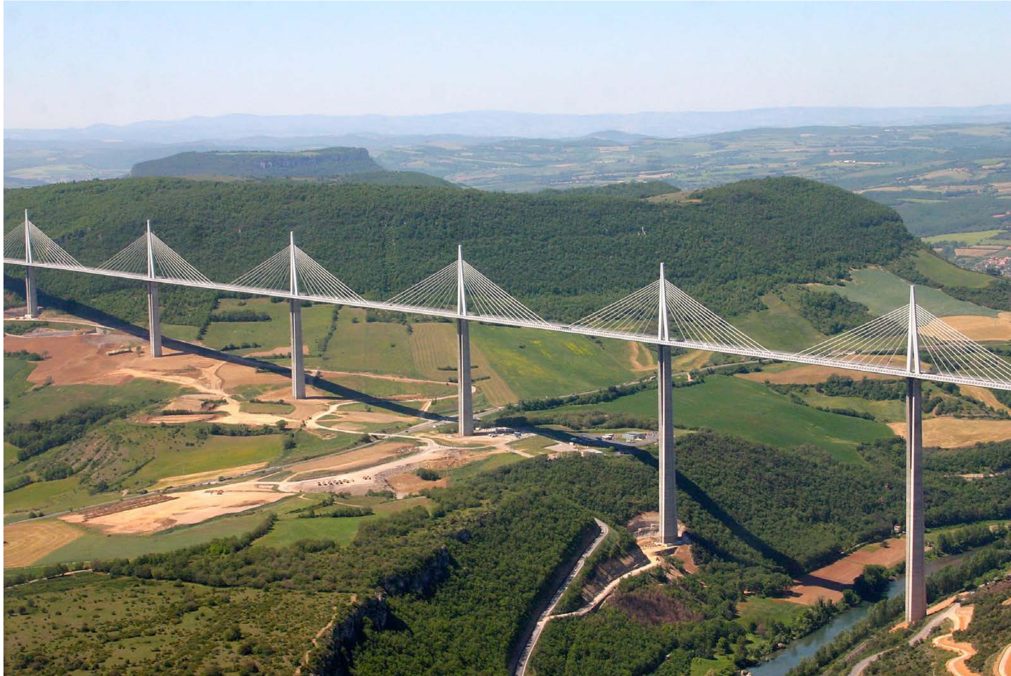
Norman Foster, Michel Virlogeux: Viaduct de Millau, Aveyon, 2004
