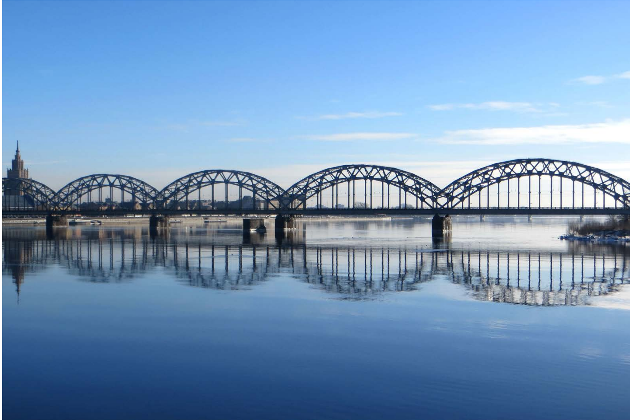
Eisenbahnbrücke, Riga, Lettland, 1914
