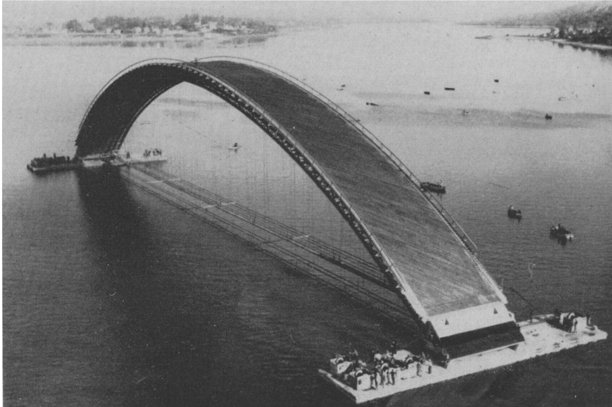
Eugène Freyssinet: Pont Albert Louppe, Bretagne, 1930
