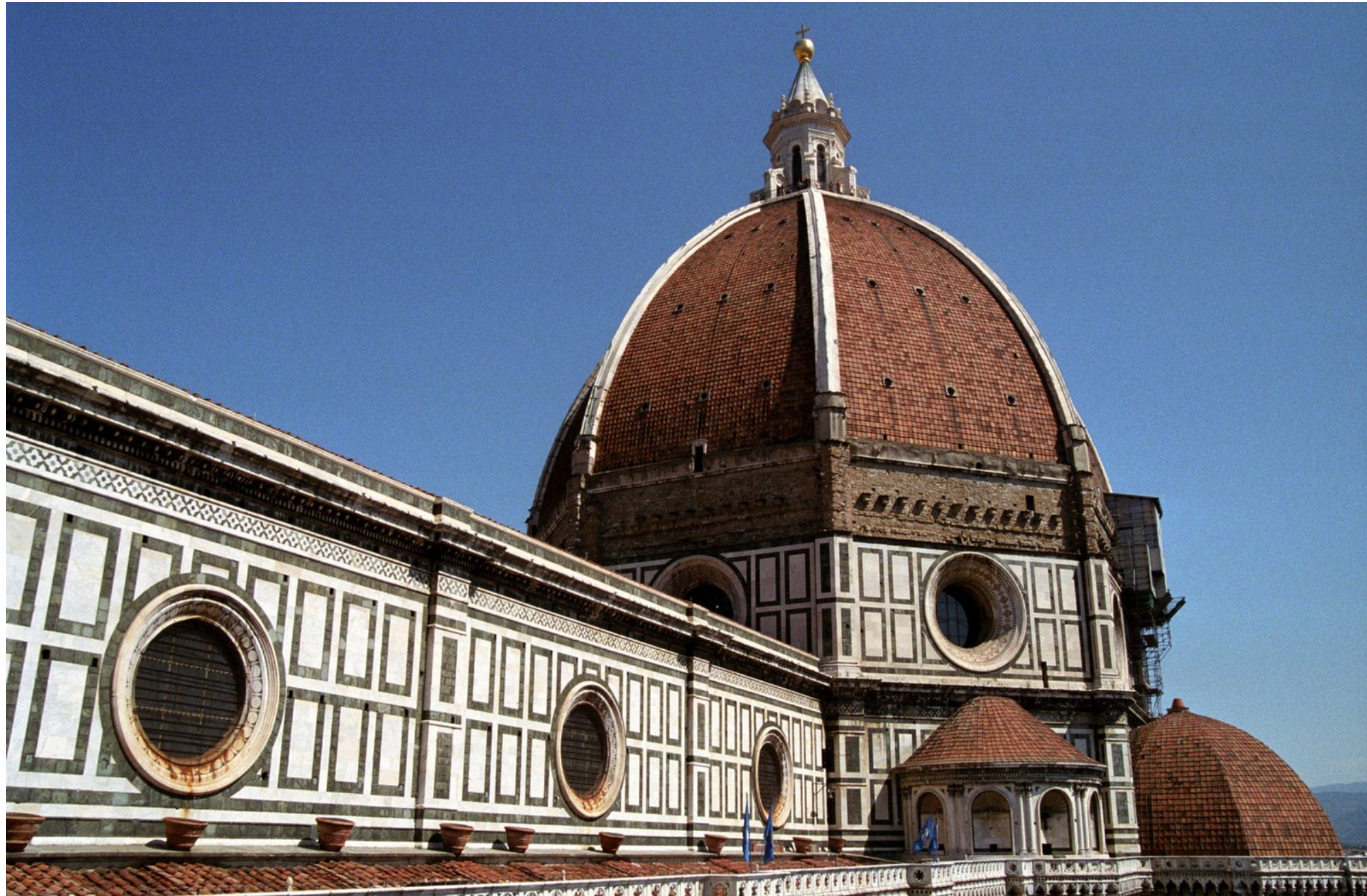
“Dome” of Santa Maria del Fiore, Arch. & Ing.: Filippo Brunelleschi, Florenz, 1418
