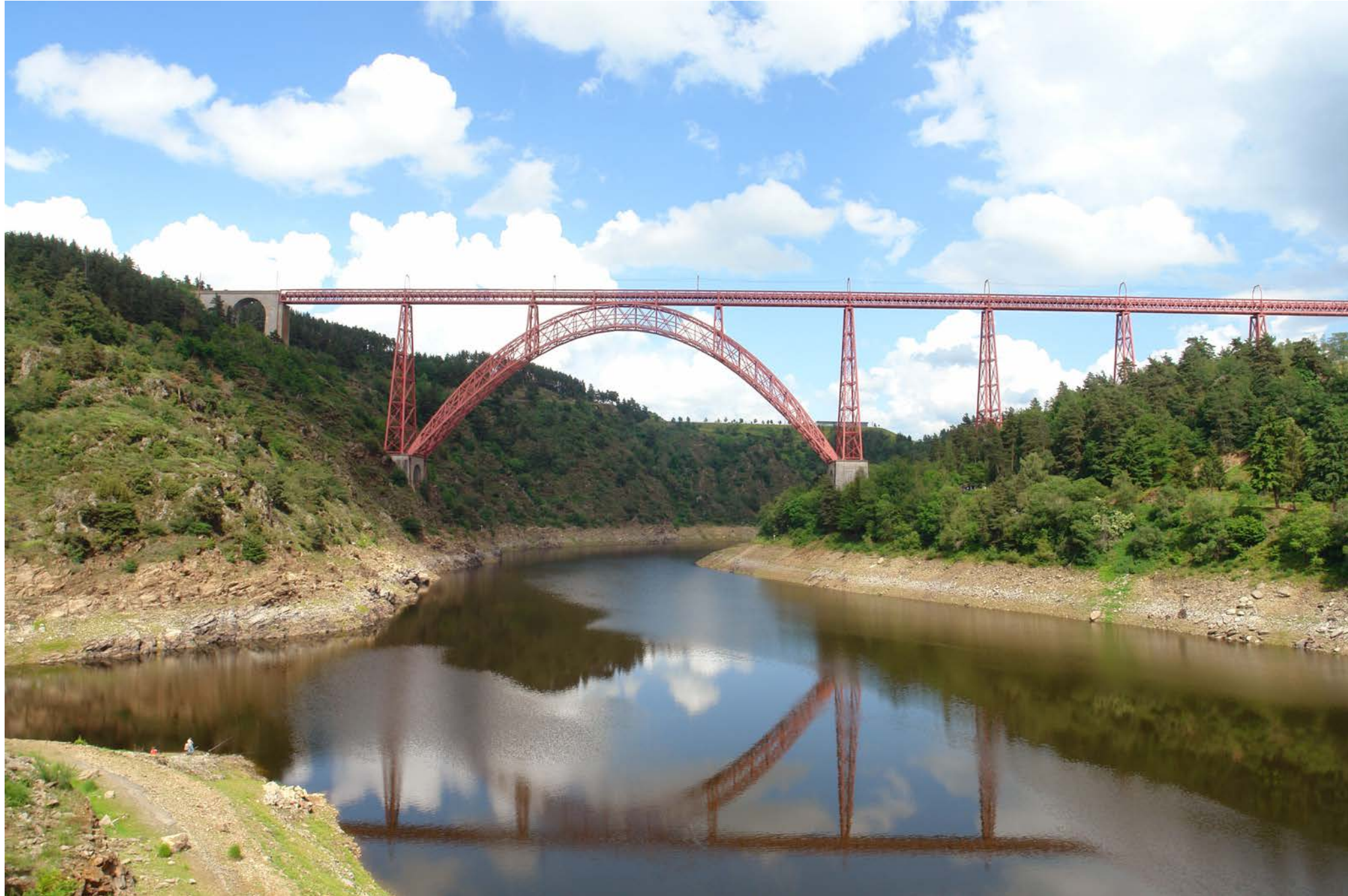
Gustave Eiffel, M. Koechlin: Viadukt Garabit, Ruynes, 1884
